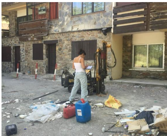
Ejecución penetrómetro P1
